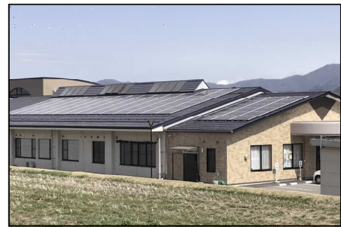
設置した太陽光設備
