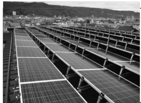
【屋根がし太陽光設備 (下諏訪)】
