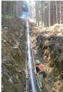
● 水圧管路敷設状況
