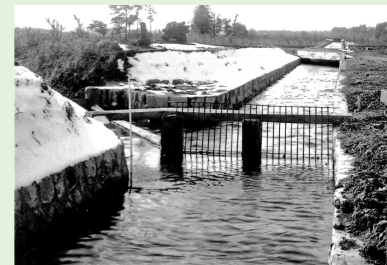
発電所導水路と平尾用水への分水点
