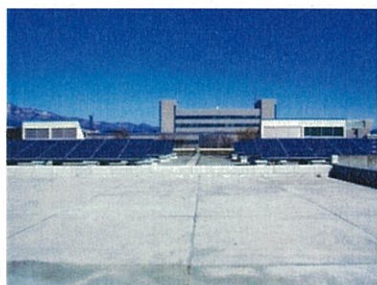
設置全体風景
