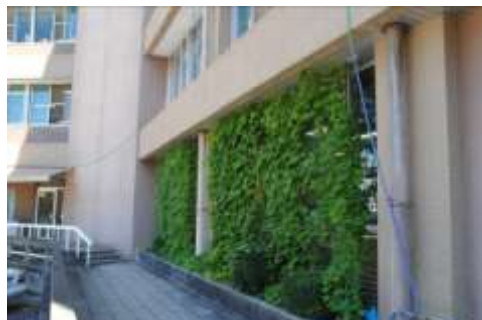
屋上から散水ホース
