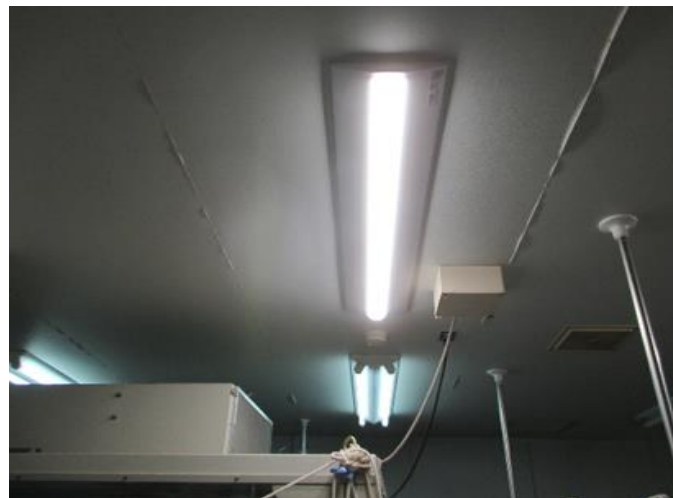
レントゲン室一部
