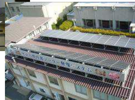
太陽光発電のPR及び発電量の掲示
