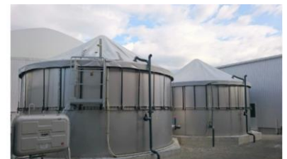
バイオガス発電 中野市
