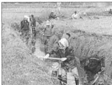
【水路の泥上げ】
