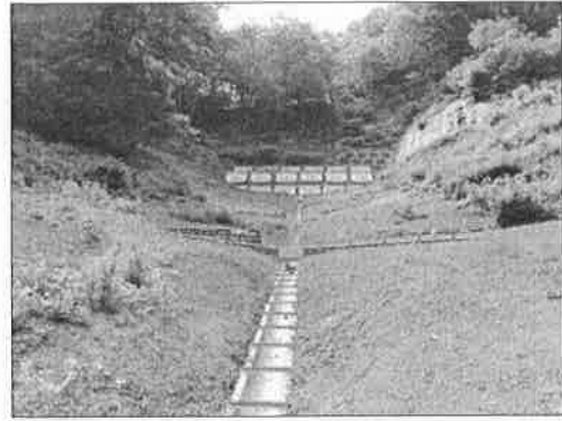
【アンカー工等の施工により地すべりを未然に防止】 地すべり対策事業 八坂地区（大町市）
