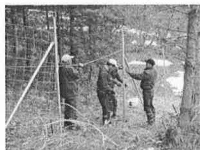
【集落住民による侵入防止柵の設置】
