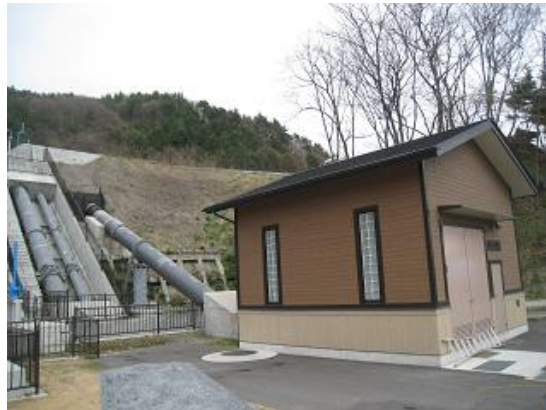
【発電施設イメージ(町川発電所, 大町市)】
