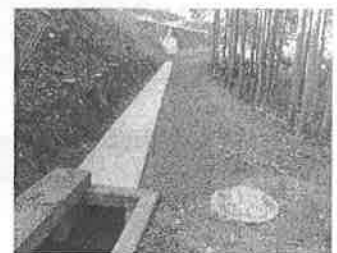
【水路改修工事(木曾町)】
