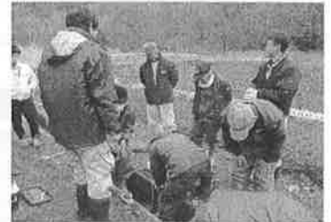
【多面的機能支払事業 水路補修研修】
