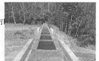
【竜西一貫水路（宮ヶ洞水路橋）】
