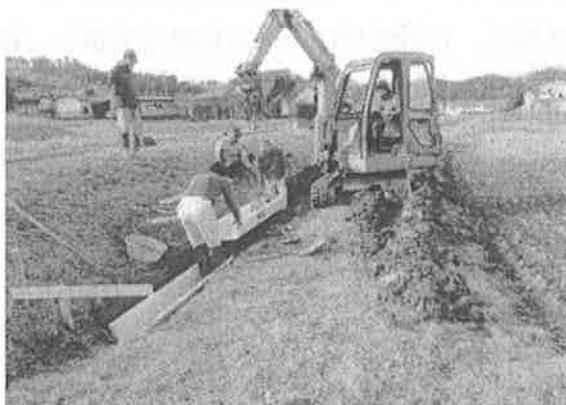
【地域住民参加による水路の直営施工】
