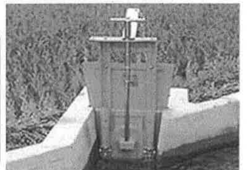
【水田への給水を自動停止する水門】
