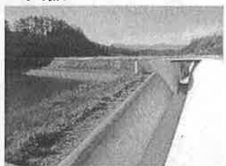
【改修されたため池】
