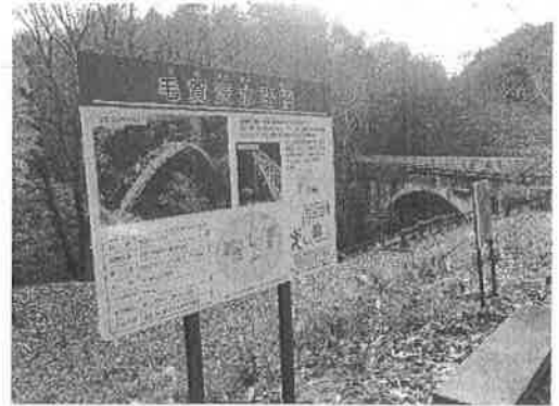
【毛賀沢水路橋に設置した案内看板】
