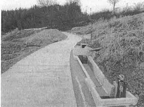
【整備した農道と用排水路】
