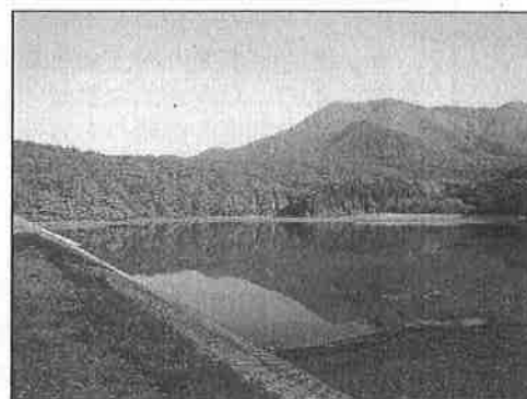
【工事が完了した浅川大池】
