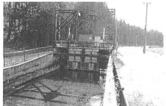
【梓川右岸幹線の落差を活用した小水力発電（松本市）】
