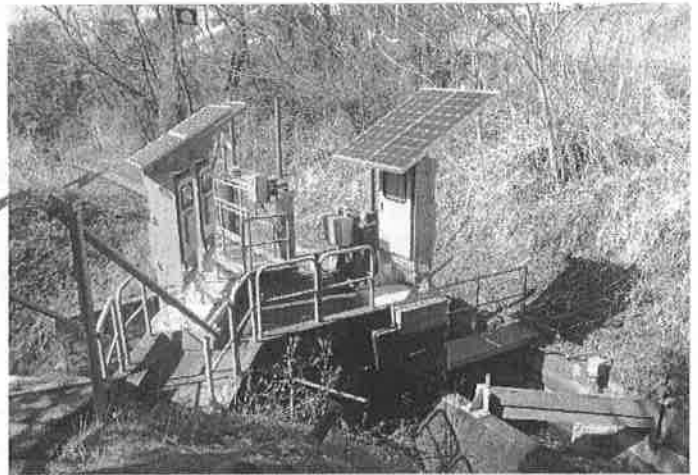
【スマートフォンによる排水門の遠方制御】
