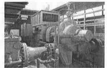
【中野揚水機場のポンプ補修】
