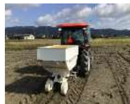
【もみ殻暗渠の施工状況】
