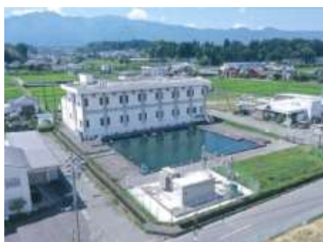
【伊那西部第一揚水機場】
