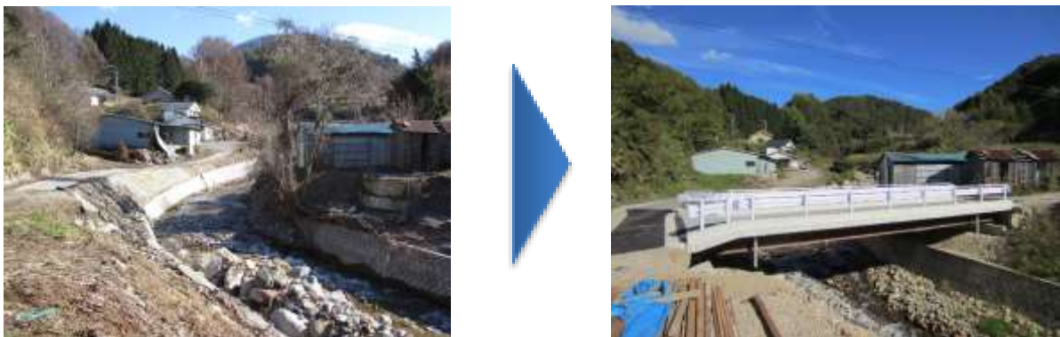
【流出した農道橋の復旧が完了（上田市）】
