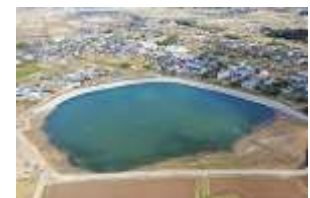
【耐震対策が完了した来光寺池】
