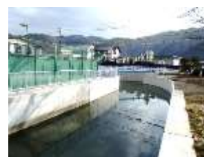
【幹線排水路の改修】
