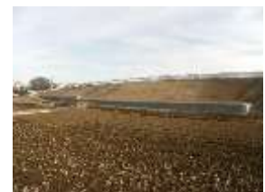
【浅科大池ため池堤体改修工事】
