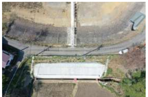
【小坂田ため池の耐震補強（塩尻市）】
