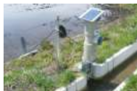
【区画拡大と合わせて遠隔操作可能な自動給水栓を整備した二重地区】
