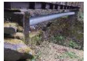
【夜間瀬剣沢地区水管橋補修】
