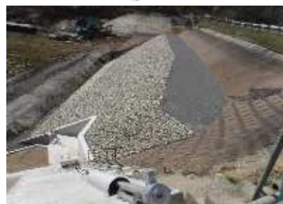
【堤体の耐震補強と緊急放流ゲートの設置】
