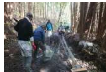
【地域住民の直営施工による水路の改修】
