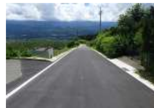
【幅員を広げて舗装した農道】
