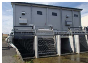
【排水機場のリノベーション】 （須坂市：相之島排水機場）
