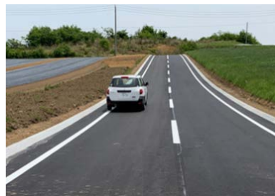
【幅員を広げて舗装した農道】
