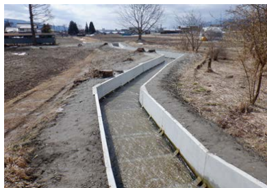
【老朽化のため更新した水路】
