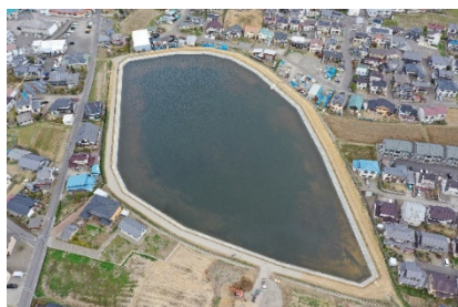
【防災重点農業用ため池の耐震化】 （上田市：古池）
