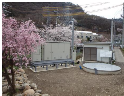
県営かんがい排水事業 【里島地区（長野市）】
