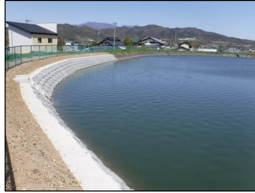
【堤体の改修により安全性が向上したため池】 県営農村地域防災減災事業 西塩田地区（上田市）
