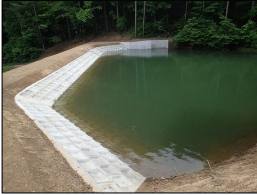
【堤体・洪水吐の改修により安全性が向上したため池】 県営農村地域防災減災事業 牛鹿宇山地区（立科町）
