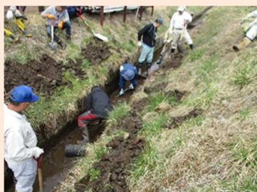
【水路の泥上げ】
