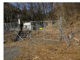
【獣害対策の防護柵整備】
