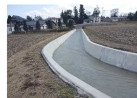
【更新した新村堰水路（松本市）】
