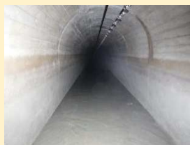
【水路トンネル 162か所】
