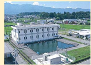
【用排水機場 67か所】
