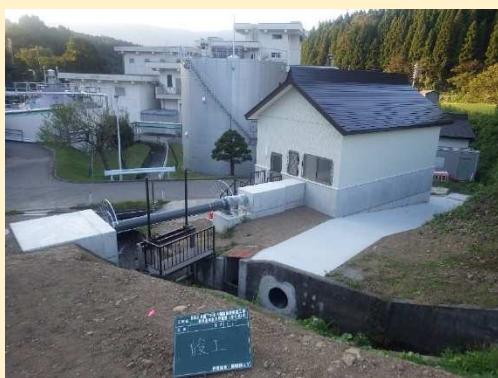
【農業用水を利用した小水力発電所（豊郷発電所：野沢温泉村）】
