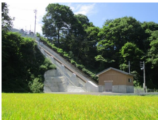
県営かんがい排水事業【春富6号地区（伊那市）】
