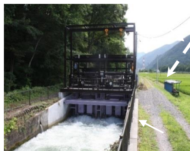
地域用水環境整備事業 【梓川右岸幹線地区（松本市）】
