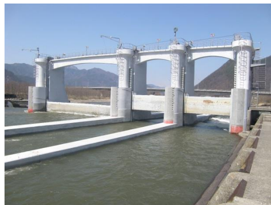
【表面被覆により劣化の進行を抑制】
