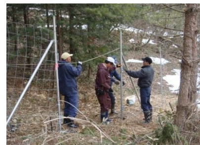
【集落住民による侵入防止柵の設置】
