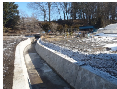
【完成した滝之湯堰】
