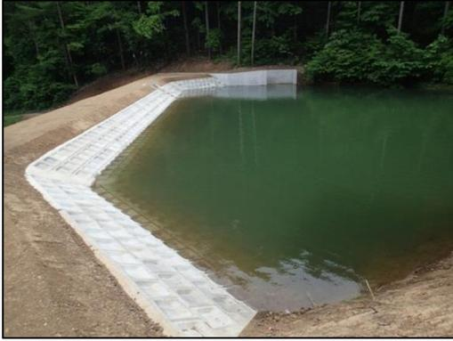
【堤体・洪水吐の改修により安全性が向上したため池】
