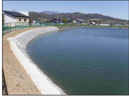
【堤体の改修により安全性が向上したため池】
