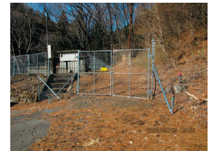
【獣害対策の防護柵整備】
