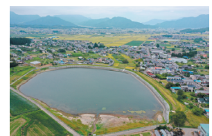
【対策済みのため池】
