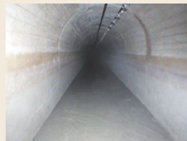
【水路トンネル 162か所】
