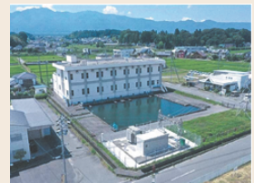
【用排水機場 67か所】
