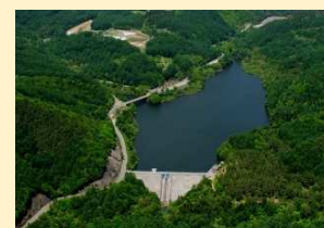
【農業用ダム・ため池 37か所】
