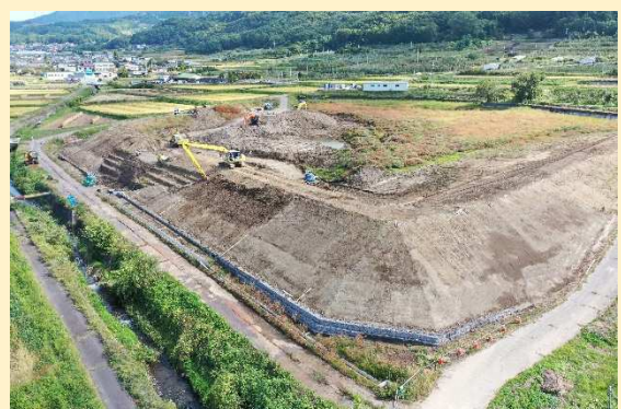
【ため池堤体の改修：吉田池（上田市）】
