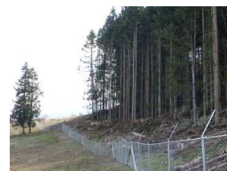
【侵入防止柵の設置】
