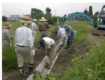
【水路の泥上げ】
