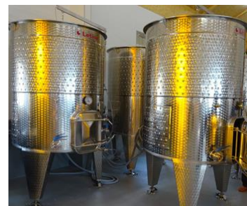
【整備された醸造施設・内部】
