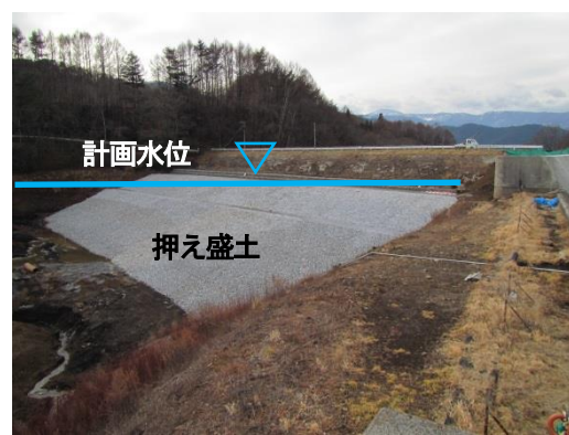
【耐震化工事が進む みどり湖（塩尻市）】
