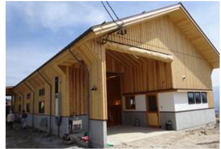
【整備された醸造施設・外観】
