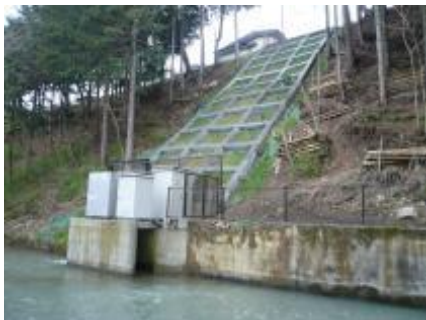
【県営かんがい排水事業 波田堰地区（松本市）】
