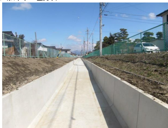
【更新後：更新により漏水等が解消】
