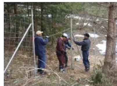
【集落住民による侵入防止柵の設置】
