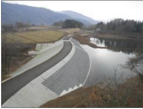
【堤体の改修により安全性が向上したため池】 県営農村地域防災減災事業 岡山地区（飯山市）
