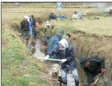
【水路の泥上げ】
