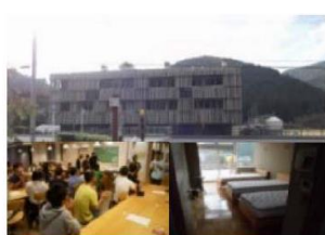
廃校を利用した交流施設
