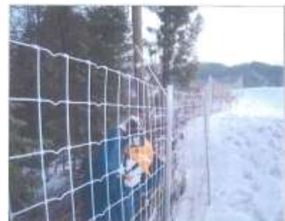
【野生鳥獣侵入防止柵の設置】
