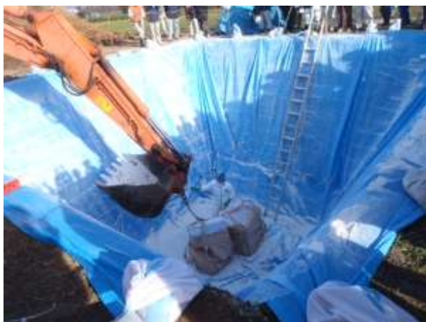
【殺処分した家畜を処分するための埋却溝掘削訓練】
