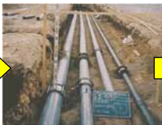
新しい管水路への更新整備
