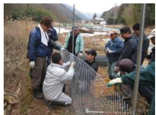
【集落住民による防護柵の共同設置作業】
