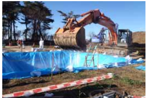
【防疫演習における埋却溝掘削】
