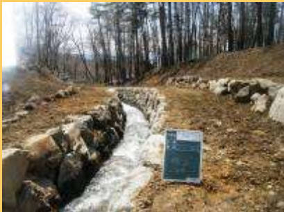
生態系や景観に配慮した水路の整備
