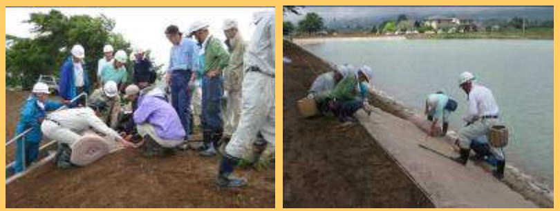
ため池の護岸整備(直営施工の状況)
