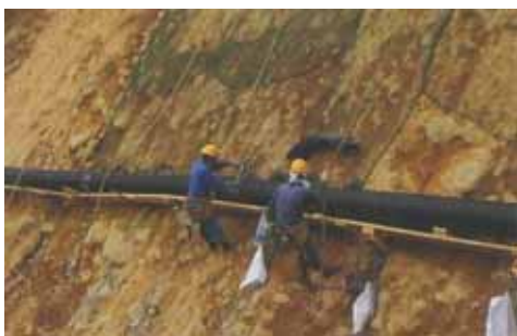
【仮設復旧した水路（栄村志久見地区）】
