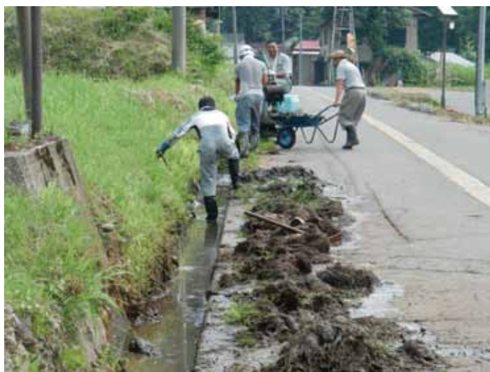
【皆で水路の泥上げ作業】
