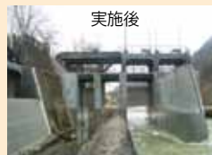
【長寿命化のための機械設備の更新、コンクリート補修を実施】
