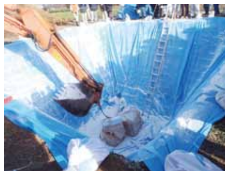
【殺処分した家畜を処分するための埋却溝掘削訓練】
