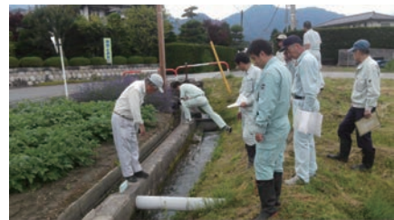
【農業用水路の点検】
