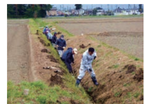
【共同活動による排水路の泥上げ】
