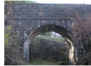
【農業遺産・久保洞水路橋】
