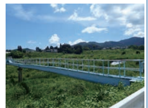
【農業用水を送水する水管橋】
