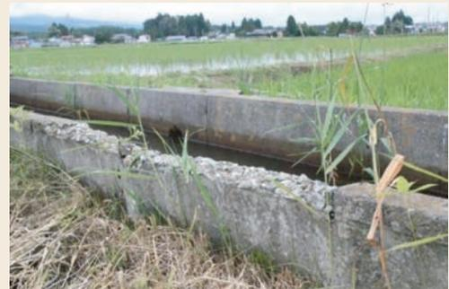
【老朽化により機能が低下している用水路】
