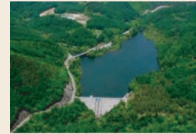
【農業用ダム・ため池 37 か所】
