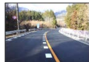
【飯島地区の農道路路面改修】
