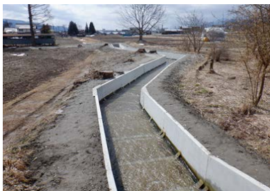
【老朽化のため更新した水路】
