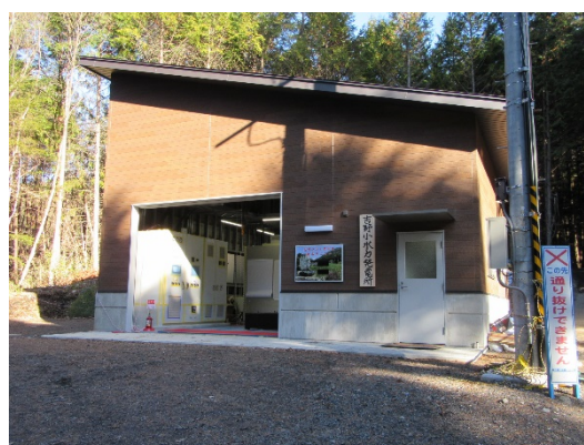
【農業用水を利用した発電施設（上松町）】
