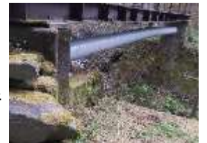
【夜間瀬剣沢地区水管橋補修】
