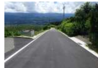
【幅員を広げて舗装した農道】
