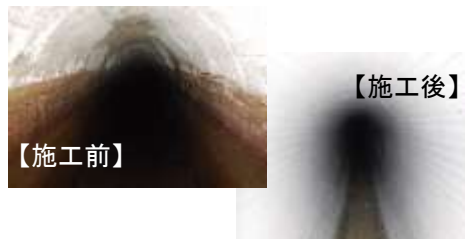
【農業用水の安定供給が可能となった芋川隧道】
