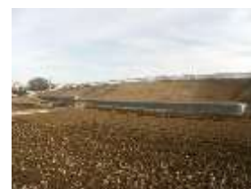
【浅科大池ため池堤体改修工事】
