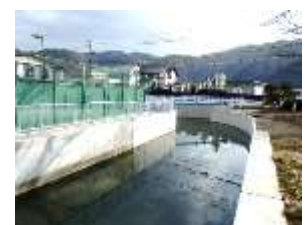
【幹線排水路の改修】
