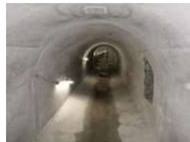
【黒川地区鷹岩隧道（水路トンネル）改修】
