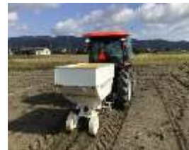
【もみ殻暗渠の施工状況】
