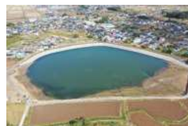
【防災重点農業用ため池の耐震化】
