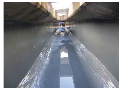
【花の里地区 水路橋内面補修後】
