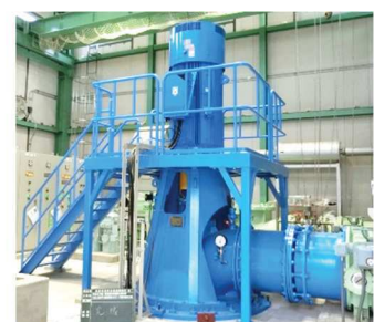
【改修した牛島排水機場ポンプ】
