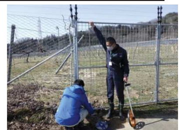
【ぶどう団地を囲む侵入防止柵整備】
