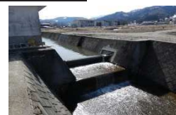
【飯山中部地区頭首工】
