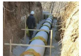
【御牧原 2 号幹線管水路更新】
