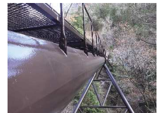
【塗装した生田寺沢水管橋】
