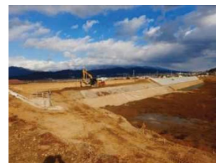
【塩田地区 手洗池の耐震化工事】
