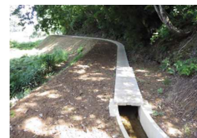
【整備が完了した山腹水路】
