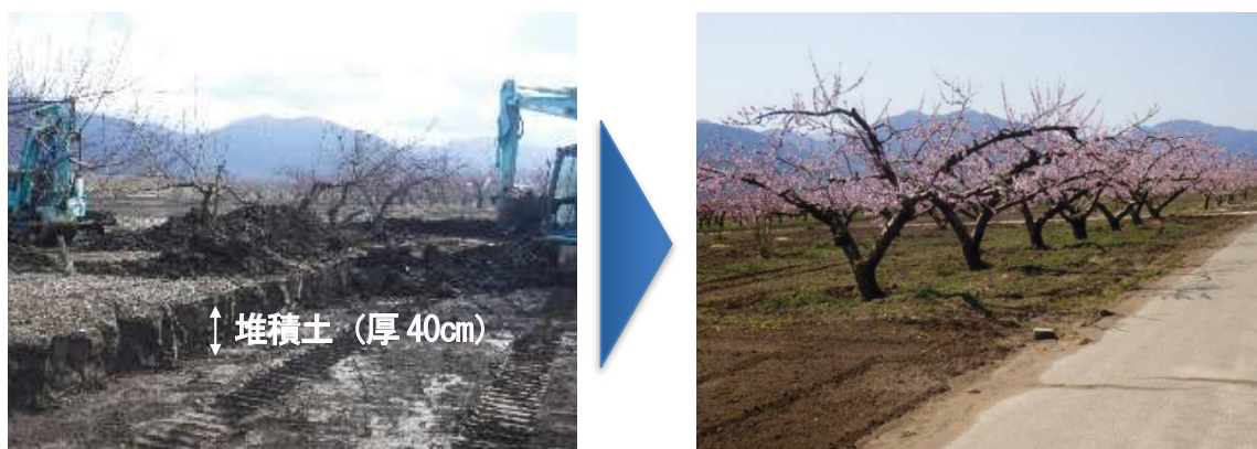
【樹園地に堆積した土砂の撤去が完了（須坂市）】
