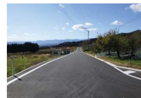
【幅員を広げて舗装した農道】
