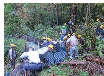
【地域住民の直営施工による獣害防止柵の補修】
