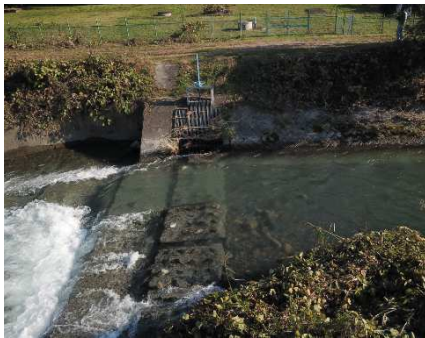
【頭首工改修前】
