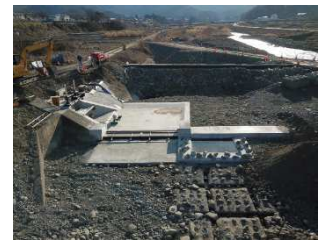
【鎖川地区（頭首工改修）】
