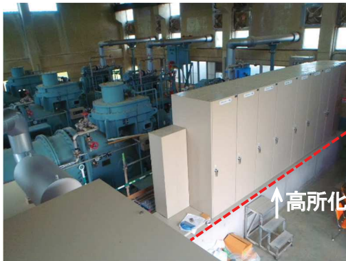
【ポンプ設備の復旧に併せて電気設備の高所化を実施（長野市 小森第一排水機場）】
