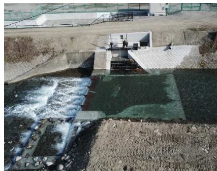
【頭首工改修後】
