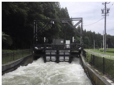
【梓川右岸幹線水路の落差を活用した小水力発電（松本市）】
