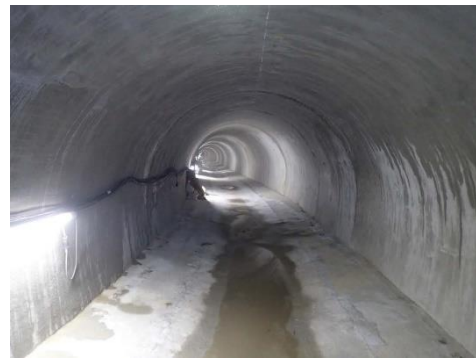
【機能回復した水路トンネル】
