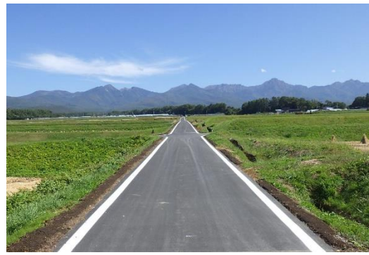
【幅員を広げて舗装した農道】
