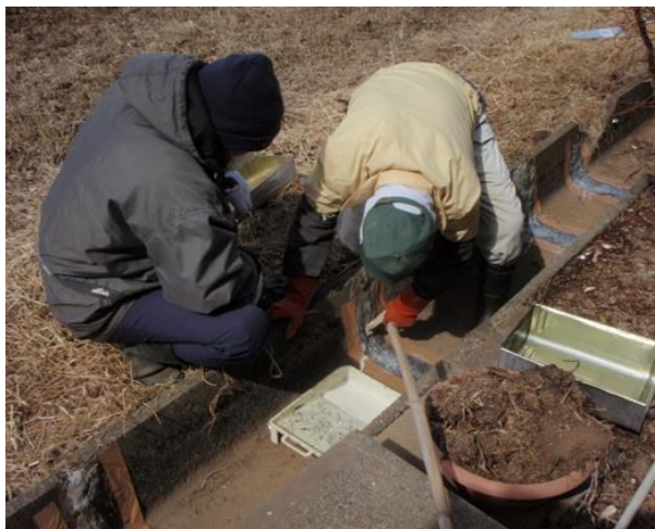
【地域住民の直営施工による水路の目地補修】
