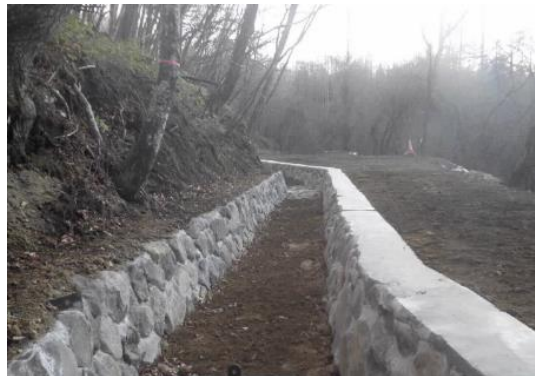
【改修工事が完了した大河原堰】
