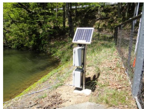
【監視カメラの設置（長野市：名知不池）】
