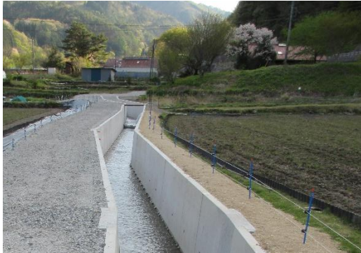
【整備が完了した用排水路】
