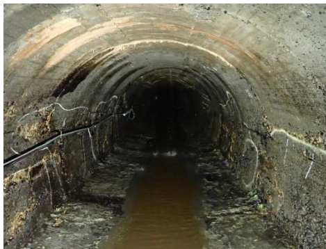
【老朽化が進んでいた水路トンネル】
