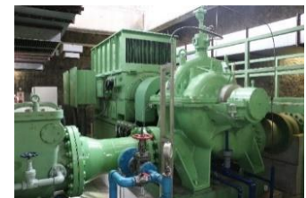
【中野揚水機場のポンプ補修】
