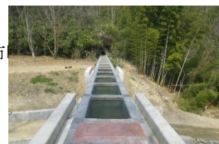
【竜西一貫水路（宮ヶ洞水路橋）】
