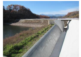
【改修されたため池】
