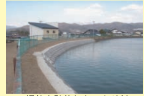
堤体を改修した ため池
