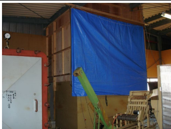
【○】 ミキサー（かくはん機）の粉塵対策の実施
