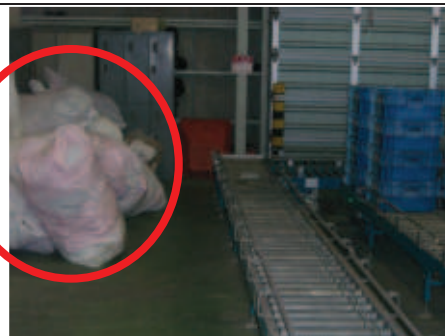
【×】廃棄物の放置
