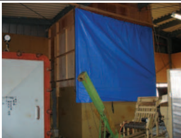
【○】 ミキサー（かくはん機）の粉塵対策の実施
