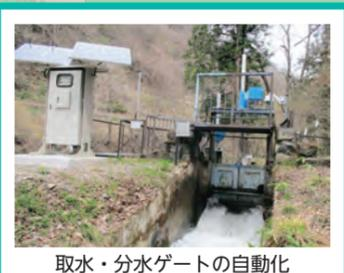
取水・分水ゲートの自動化
