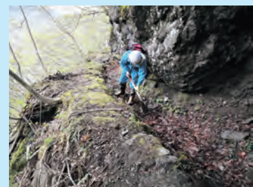
狭い箇所での通水前の堰ざらい
