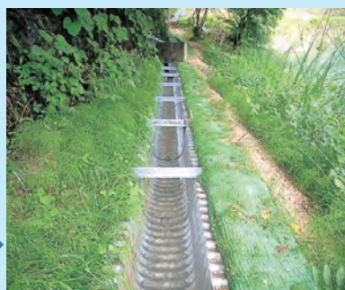
老朽化した地すべり防止施設の機能回復
