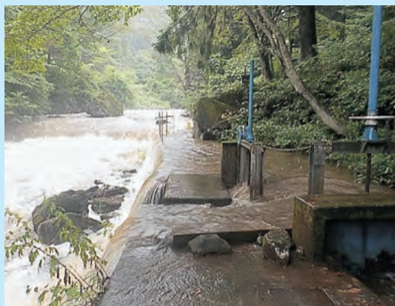
河川増水時の取水口の状況
