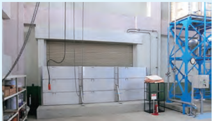
止水壁の設置 (長沼機場)
