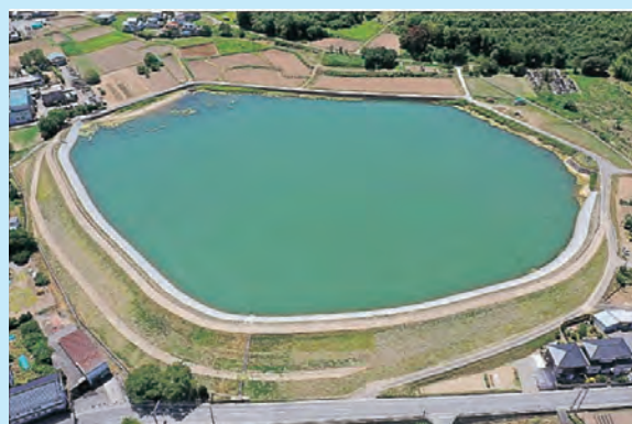
工事施工後（来光寺池：上田市）
