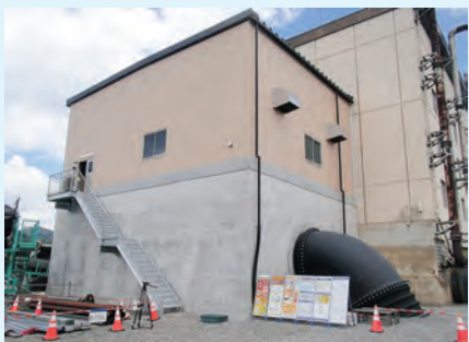
浸水を防止するための機場の高所化 (浅川機場)
