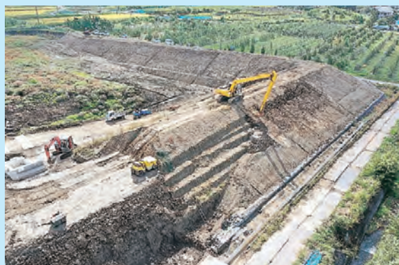
防災工事実施状況（吉田池：上田市）
