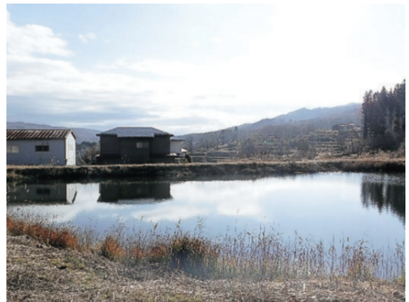
防災重点農業用ため池（岡谷市 蟹沢下ため池）
